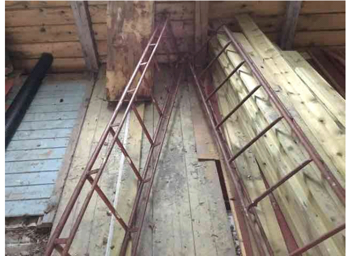
Nauste gulv oppe.
